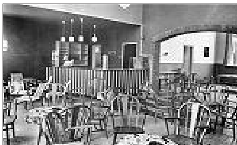
De door dienstplichtigen verbouwde en met bar en zitjes ingerichte ruimte in het Protestant Militair Tehuis, gevestigd in het voormalige gebouw van de openbare lagere school op de Hagen begin jaren '60 (foto: www.898vdbat.nl ).
