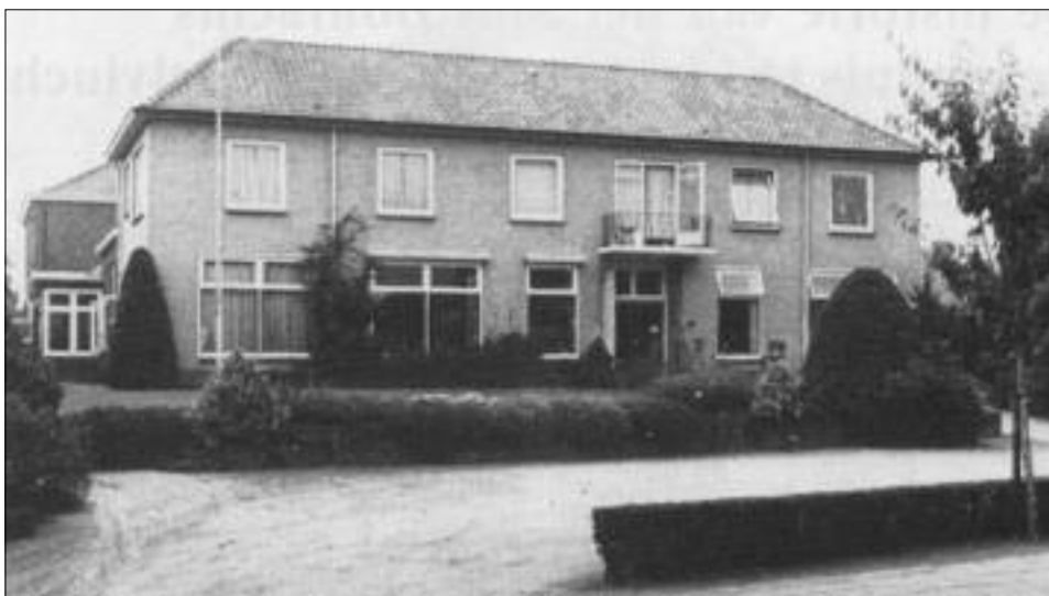
Het voormalige protestants-christelijk ziekenhuis na de verbouwing in 1950, toen in gebruik als verzorgingstehuis voor minder valide bejaarden. De foto is genomen enkele maanden na de sluiting in januari 1980 (foto uit F.J. de Leeuw, 1987).
